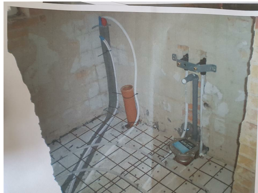
Billede 2. Sammenstripsede rør, adresse ukendt
