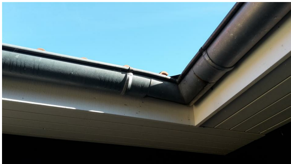
Tagrende hjørnestykke med nedbøjning
