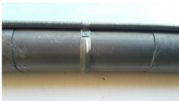
Fast tagrendestykke fremfor et ekspansionsstykke.
