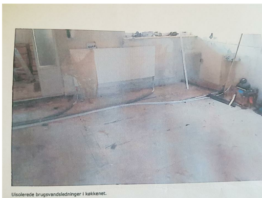
Billede 3. Sammenstripsede rør, udklip fra SlothMøllers tilsynsnotat. Adresse ukendt
