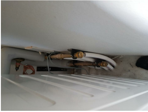
uisolerede fordelerledninger
